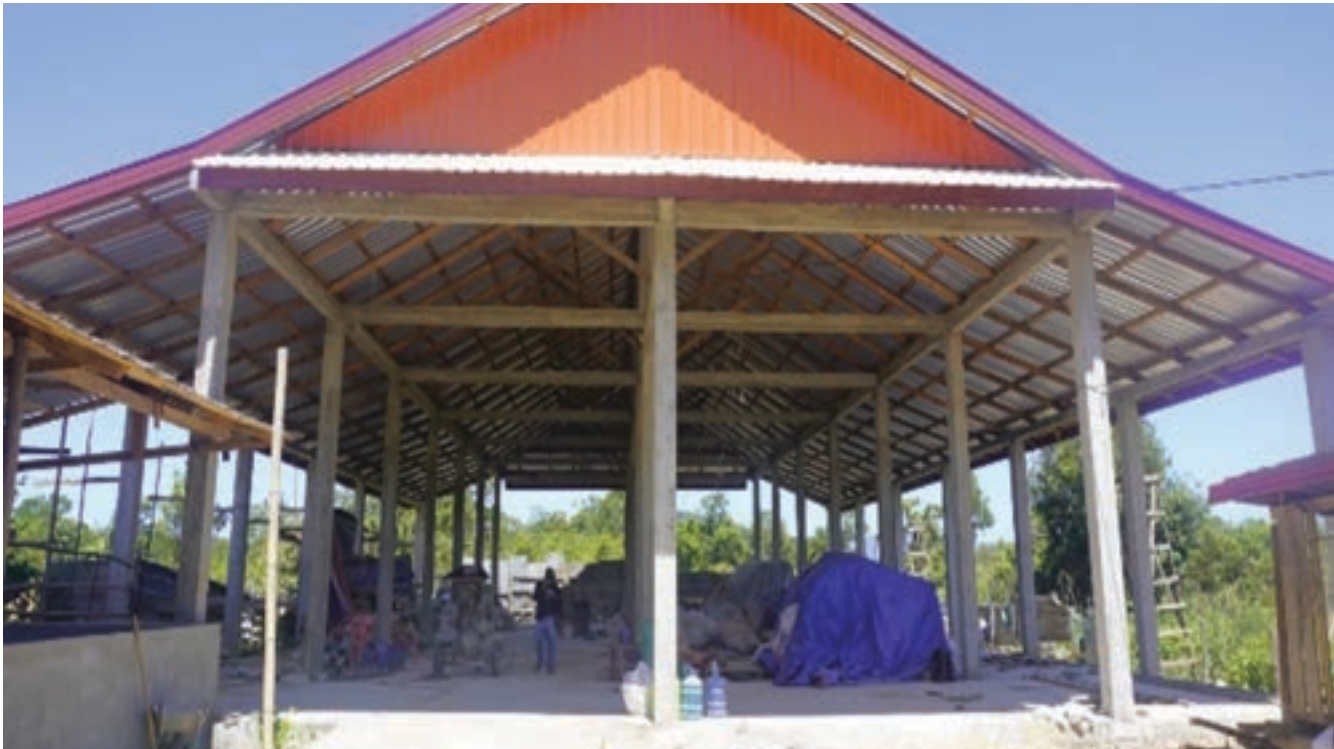
ສາງມີຄວາມພ້ອມກັບການເກັບກ່ຽວສາລີ ແລະ ເປັນສາງແບບເປີດໃຫ້ລົມຜ່ານ ເພື່ອປ້ອງກັນການເໝົາເສຍ
